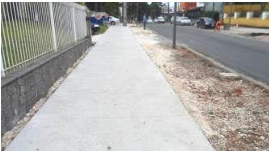
Figura 01 – Exemplo de Piso de Concreto Simples
